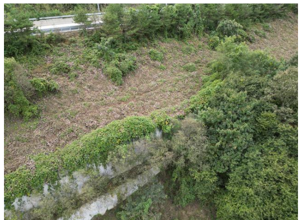
상부 성토부 전경
